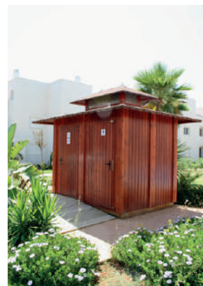
Cubierta a cuatro aguas con linterna
