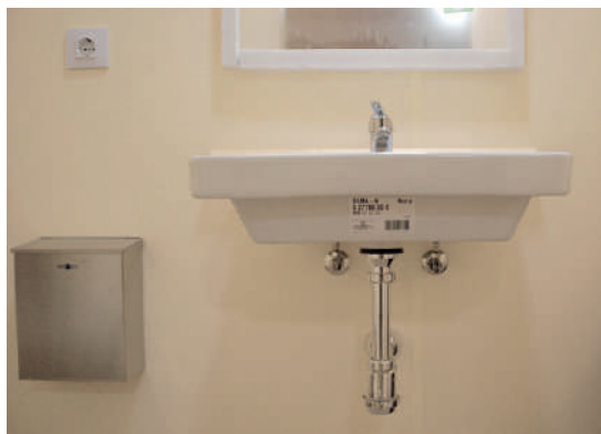
Paredes interiores en HPL / Sanitarios cerámicos suspendidos / Papelera colgada en pared.
