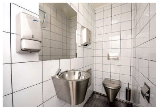
Paredes interiores alicatado azulejo / Sanitarios suspendidos de acero inoxidable / Ventilación cruzada
