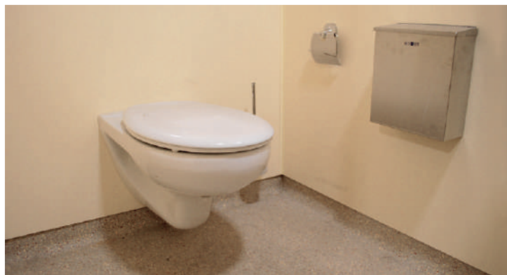
Paredes interiores en HPL / Sanitarios cerámicos suspendidos / Papelera colgada en pared.
