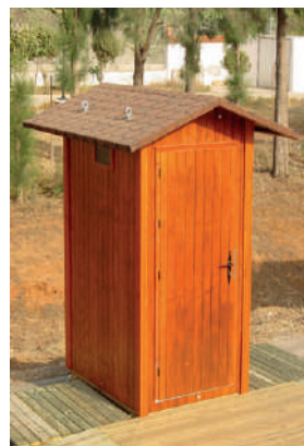
Cubierta a dos aguas
