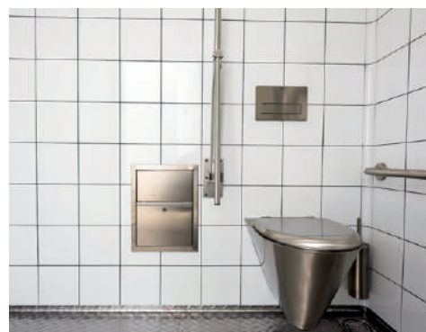
Paredes interiores alicatado azulejo / Sanitarios suspendidos de acero inoxidable / Ventilación cruzada
