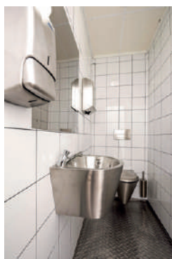
Paredes interiores alicatado azulejo / Sanitarios suspendidos de acero inoxidable / Ventilación cruzada
